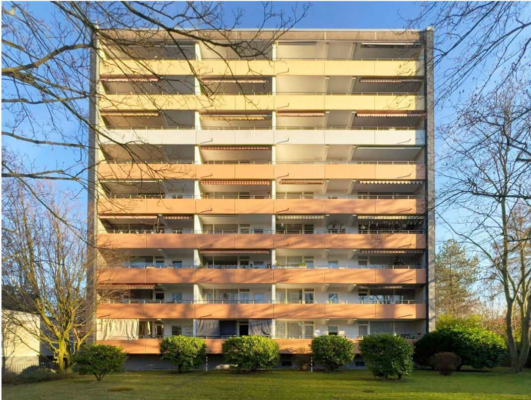
Ansicht Fassade Ostrasse
