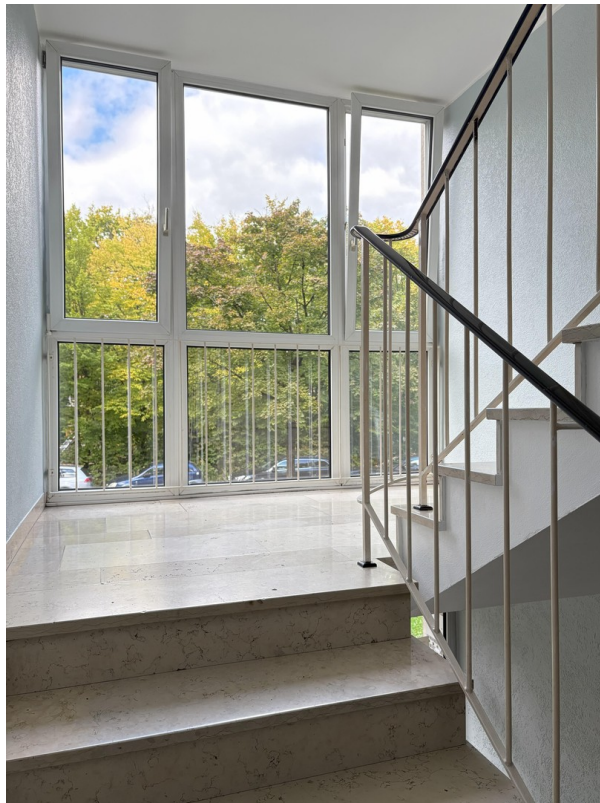
Treppenhaus (frisch renoviert)
