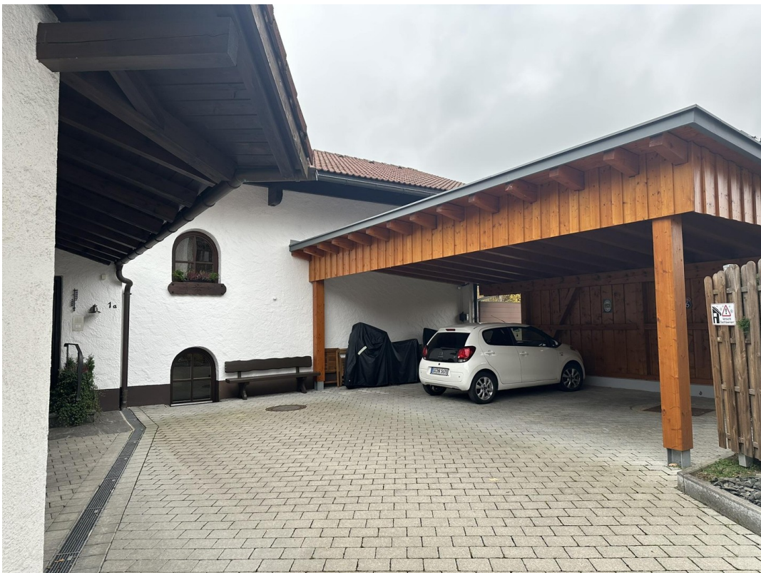
Carport mit 3 Stellplätzen
