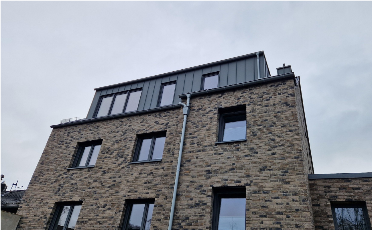
Fassade von Hofseite
