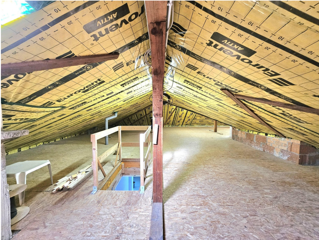
Großer gedämmter Dachboden
