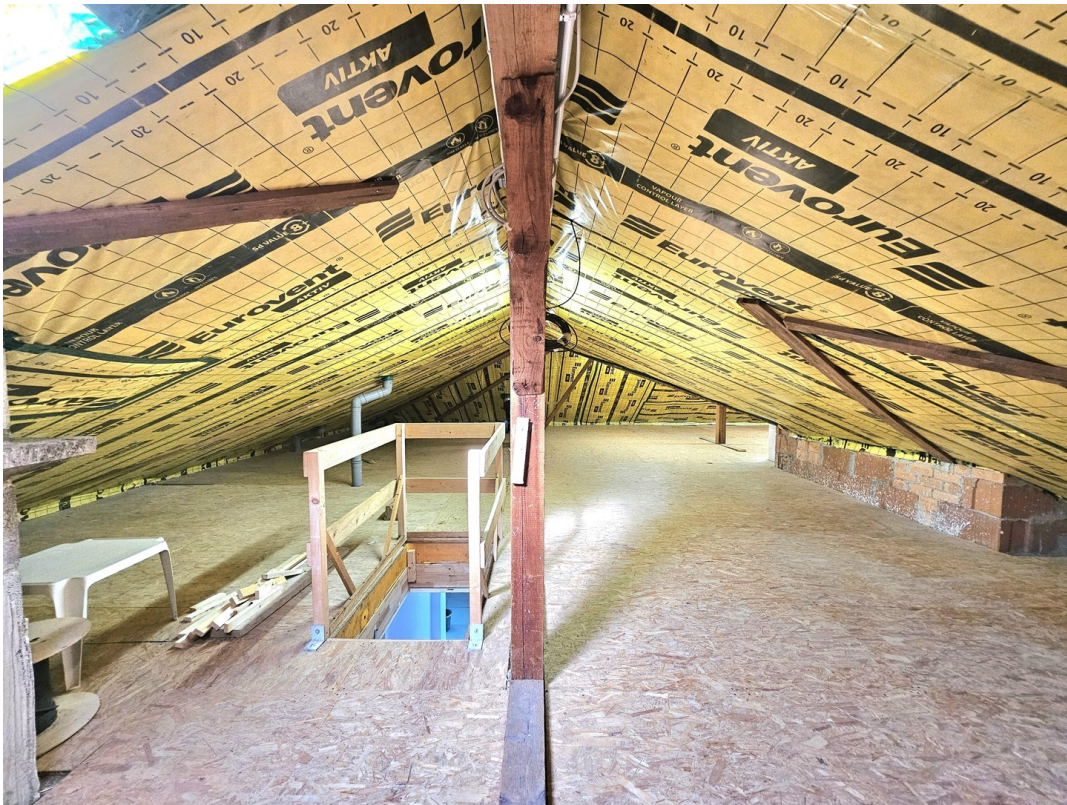
Großer gedämmter Dachboden
