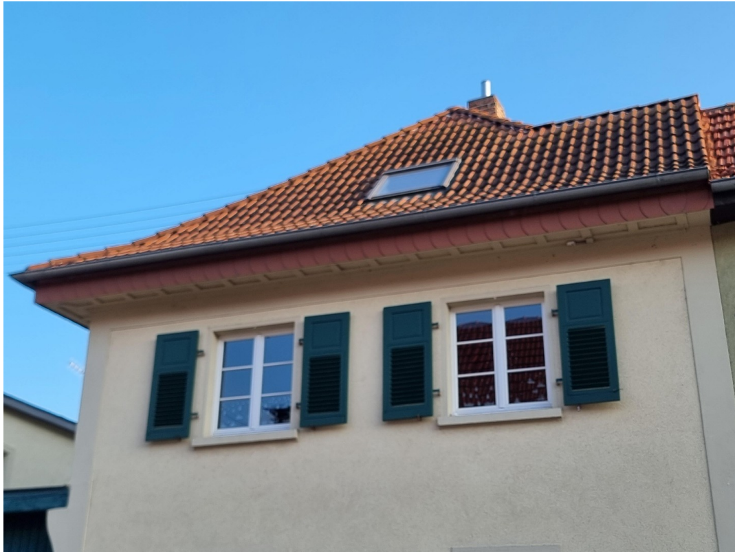
Obergeschoss mit Dachfläche
