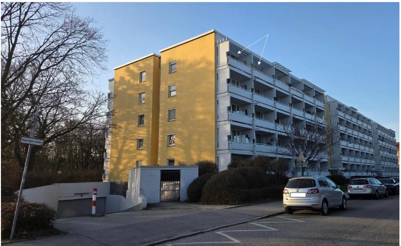
Ansicht Haus und Tiefgarage
