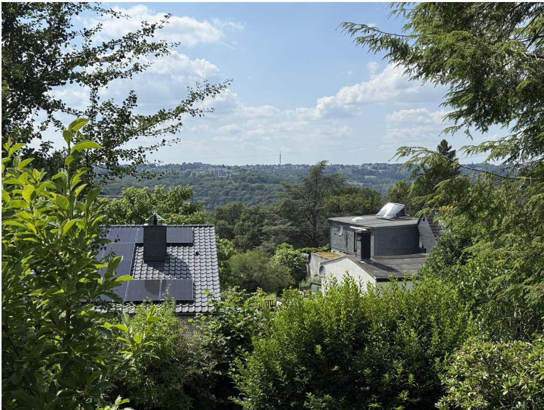
Blick v. Balkon OG nach Westen
