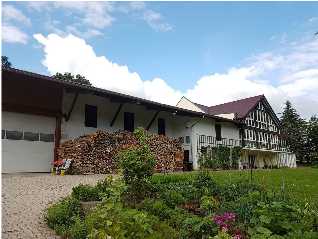
Hofansicht Süd/ West
