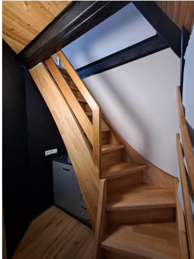
Treppe zu OG
