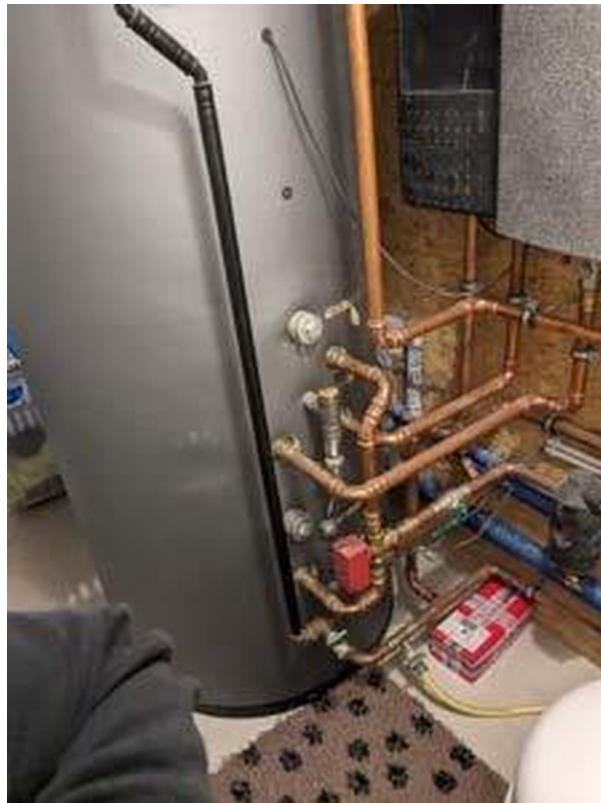
Warmwasserspeicher
