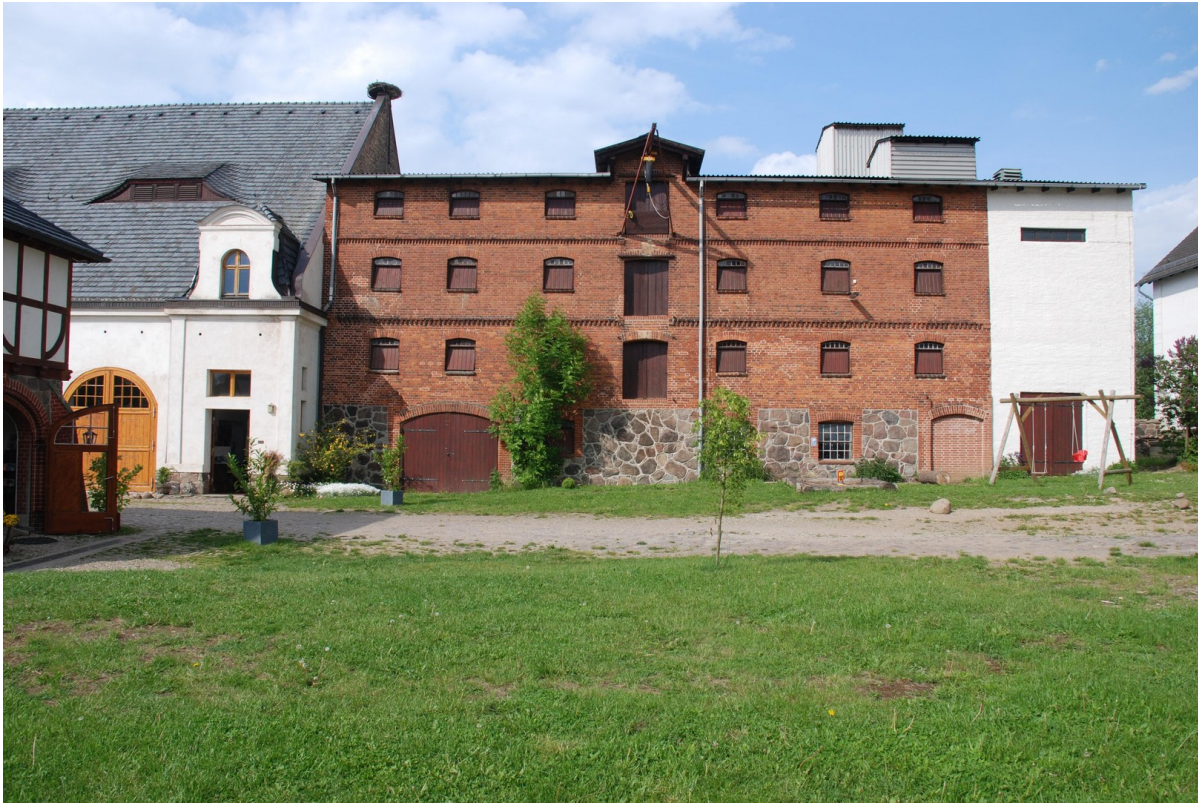
Der Speicher mit 4 Etagen...
