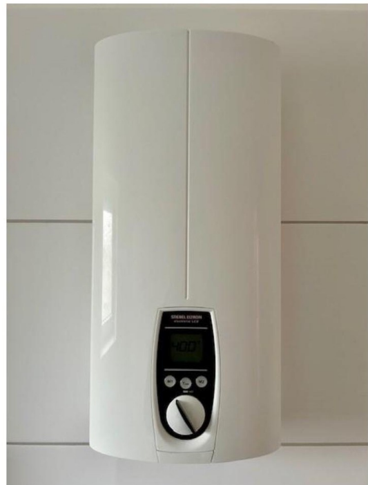
Bad mit Durchlauferhitzer
