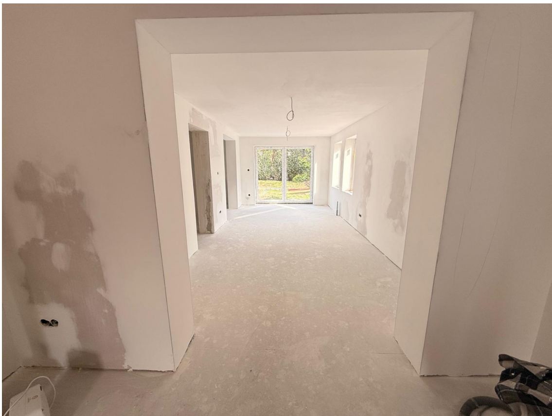
Blick ins Esszimmer
