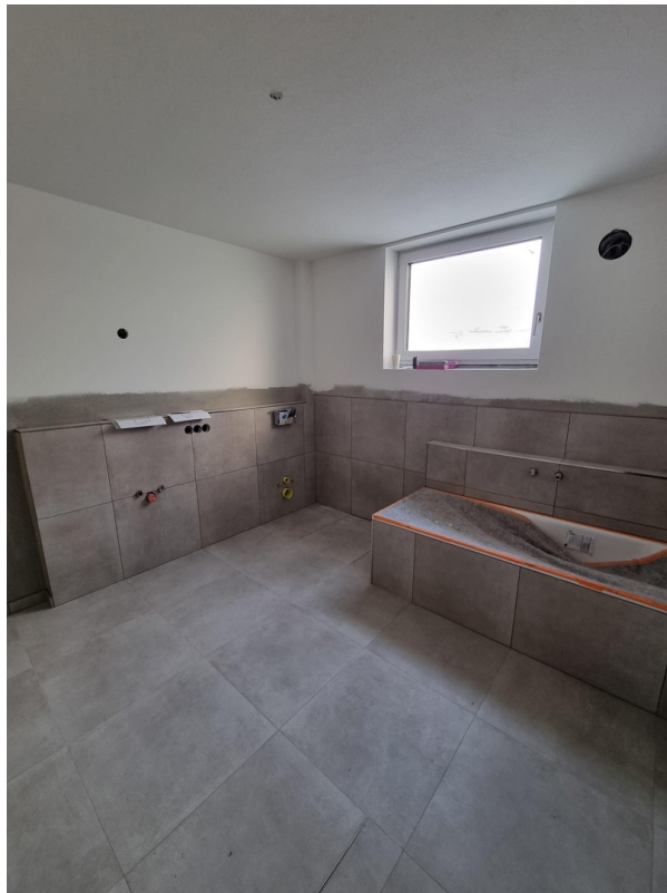
Blick ins Bad - noch unfertig
