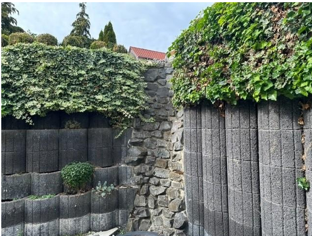
Wasserwand ELW - 2. Terrasse
