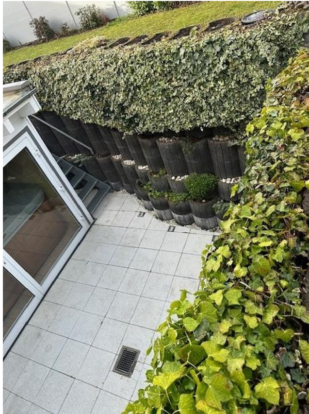
Blick 2.Terrasse ELW
