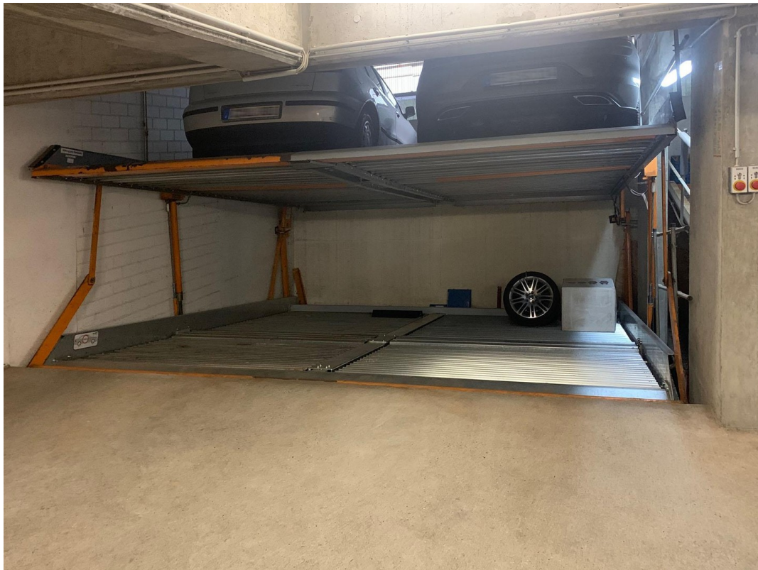
Duplex Parkplatz in Tiefgarage
