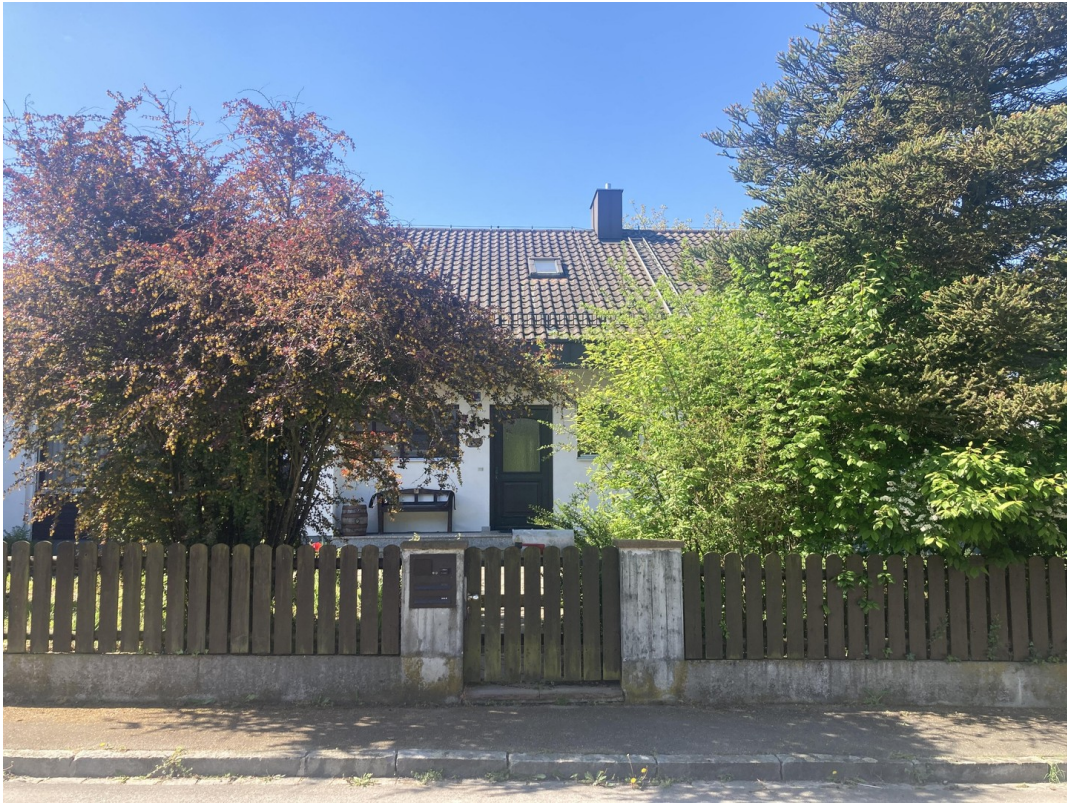
Nordseite, Eingang Straße
