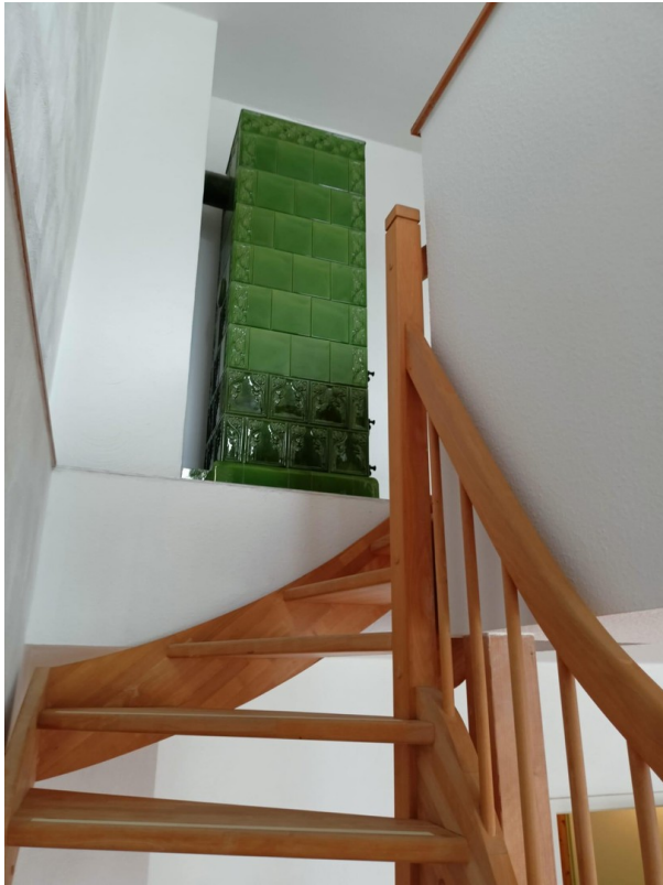
Treppe nach oben
