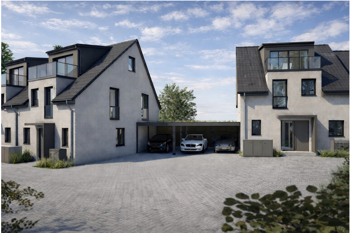
Zugang Haus 4 und Haus 3
