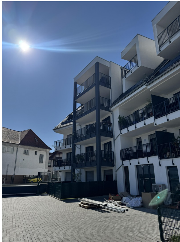
Rückseite des Wohnhauses
