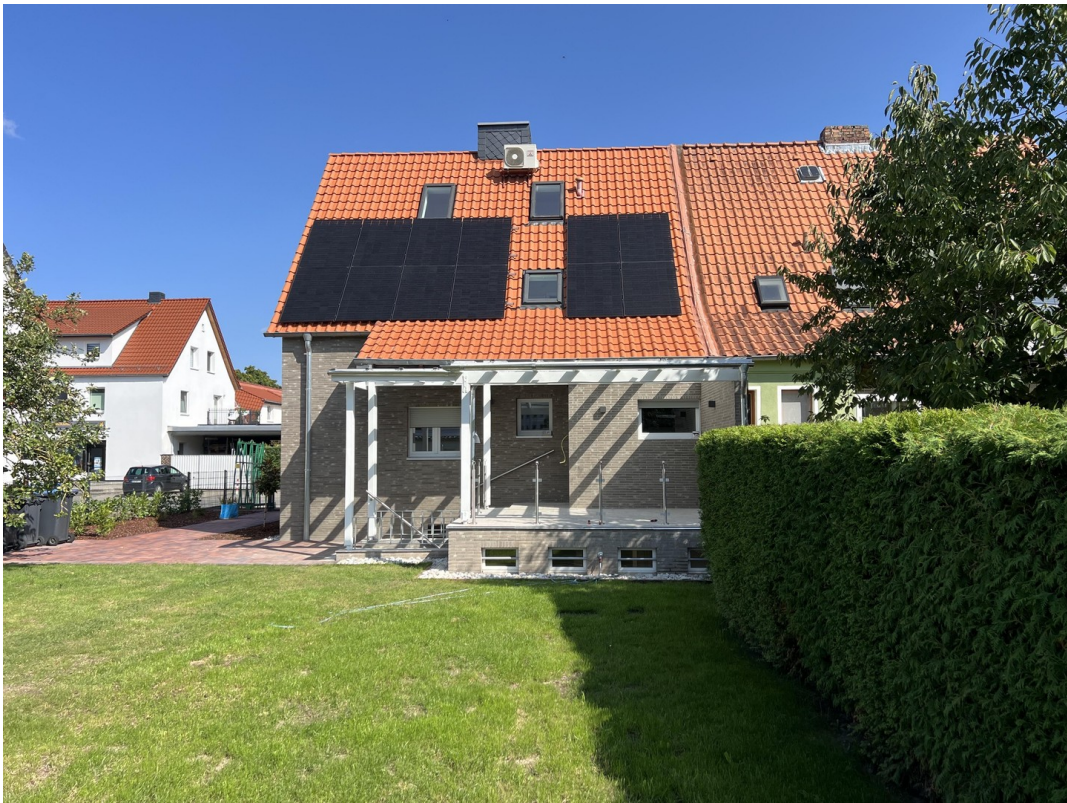
Hausrückseite, PV & Terrasse
