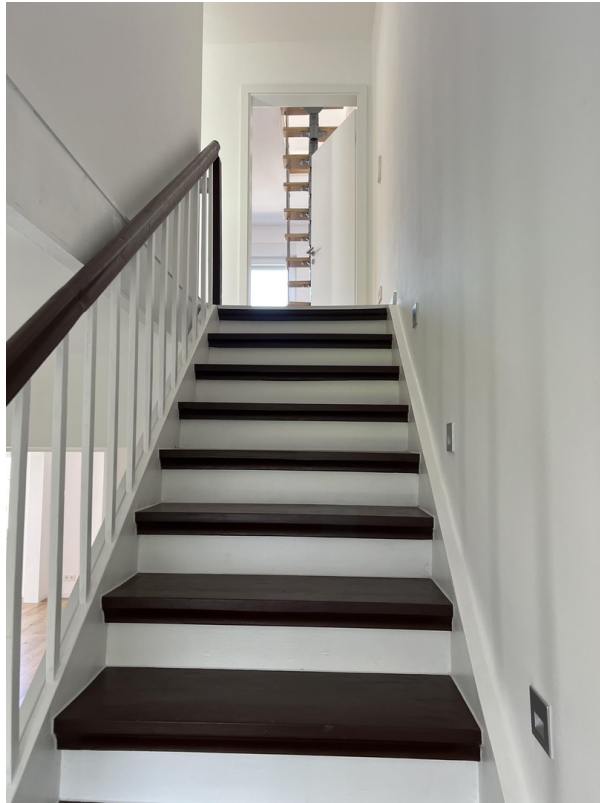
Treppe in den OG
