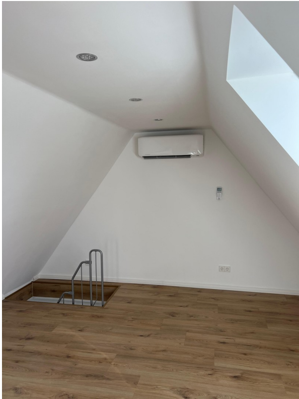
Dachstudio mit Klimaanlage
