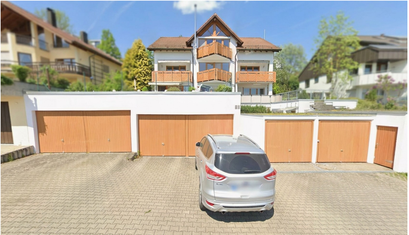
Haus und Garagen
