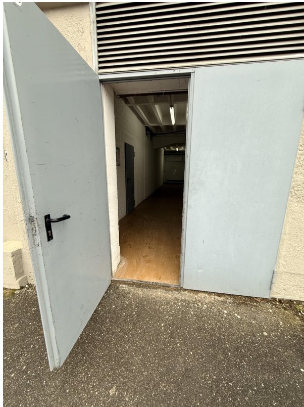
Zugang v Aussen Lager H
