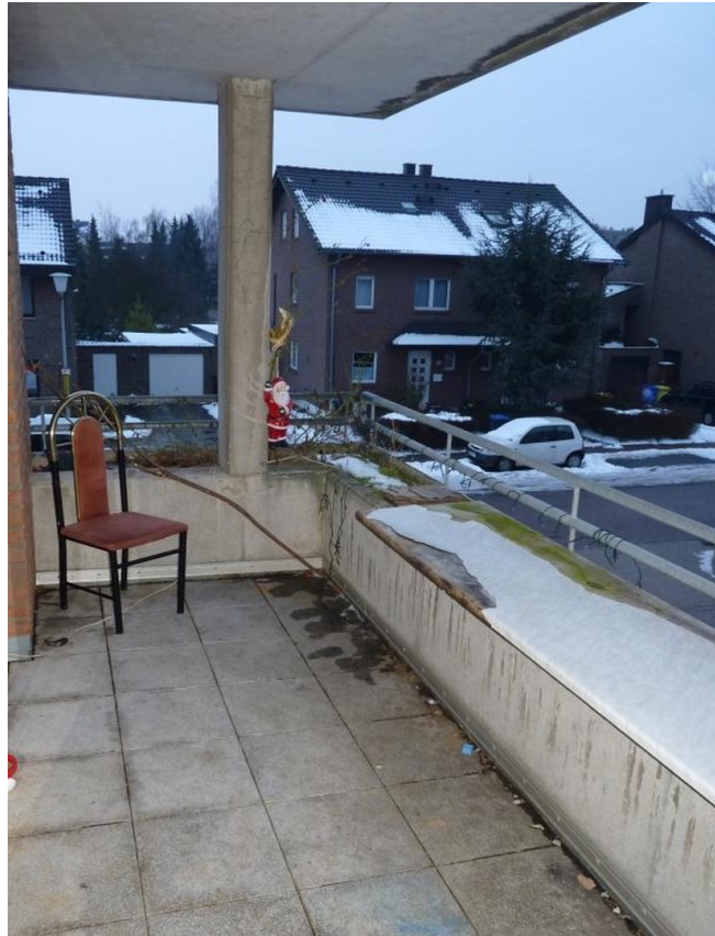
Balkon nach Südwesten
