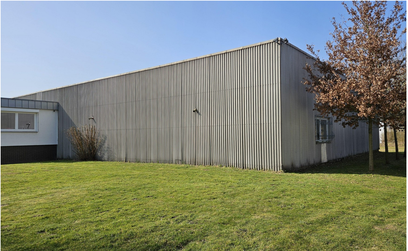
Gebäude Süd Ost
