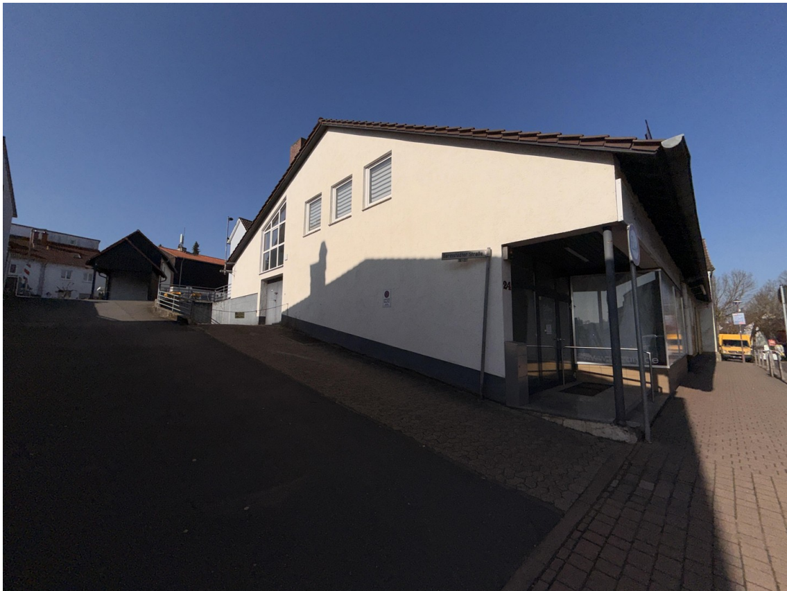
Seitenansicht des Gebäudes
