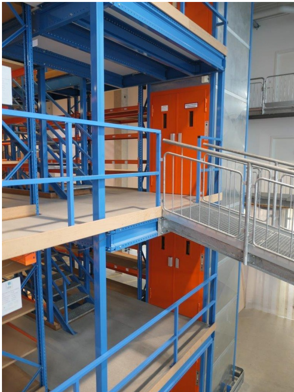
Lastenaufzug im Picklager
