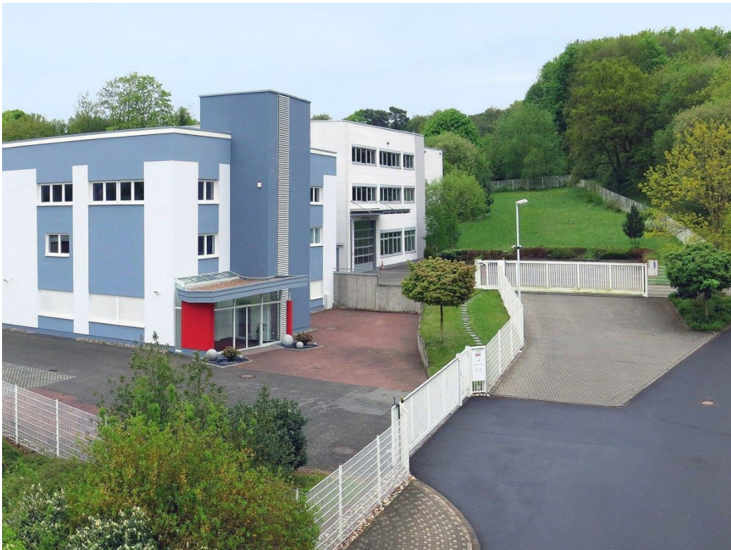
Zufahrt zum Gelände
