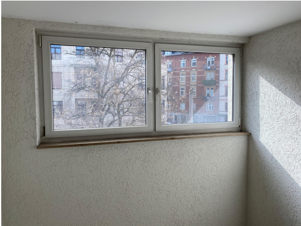
Fenster im Treppenhaus
