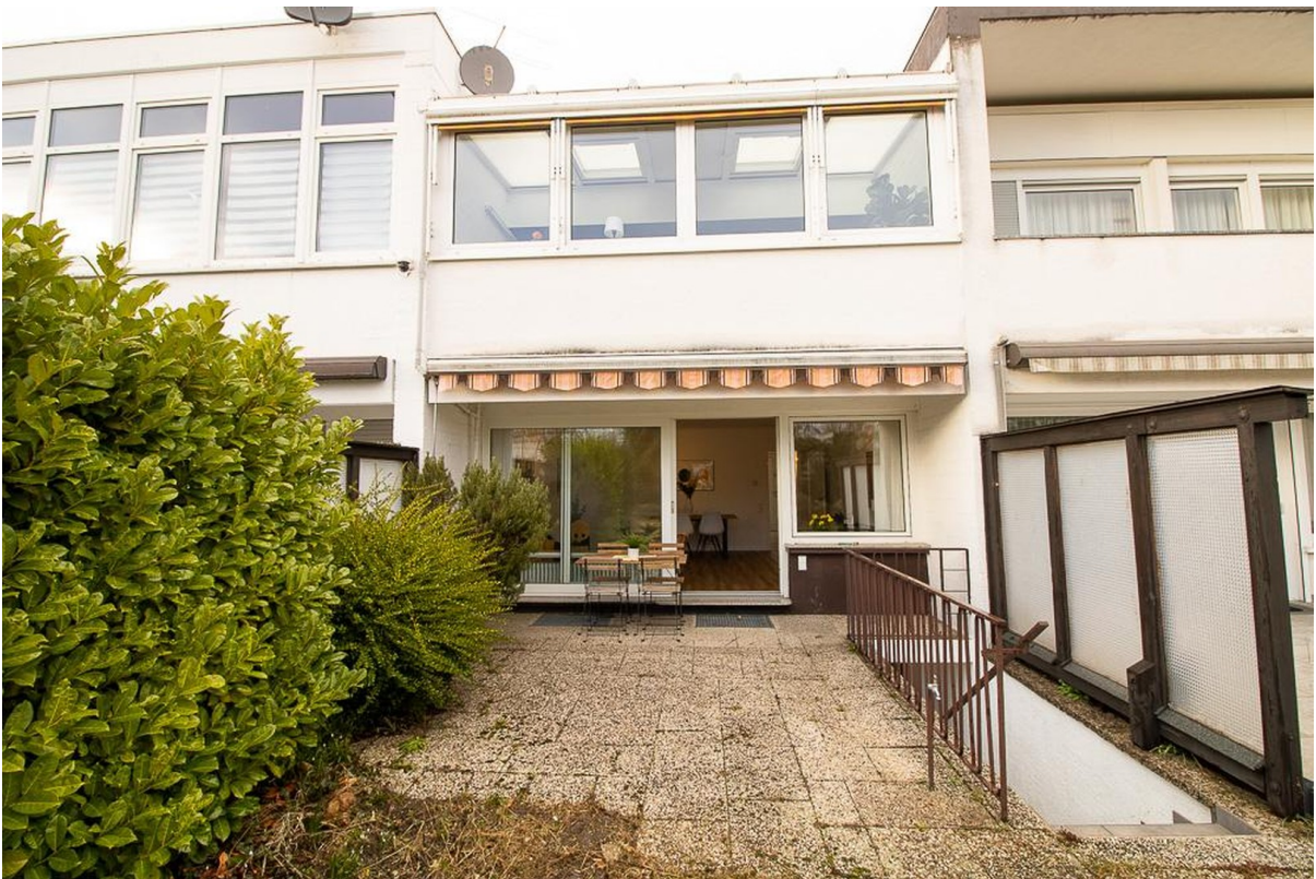
Terrasse und Wintergarten
