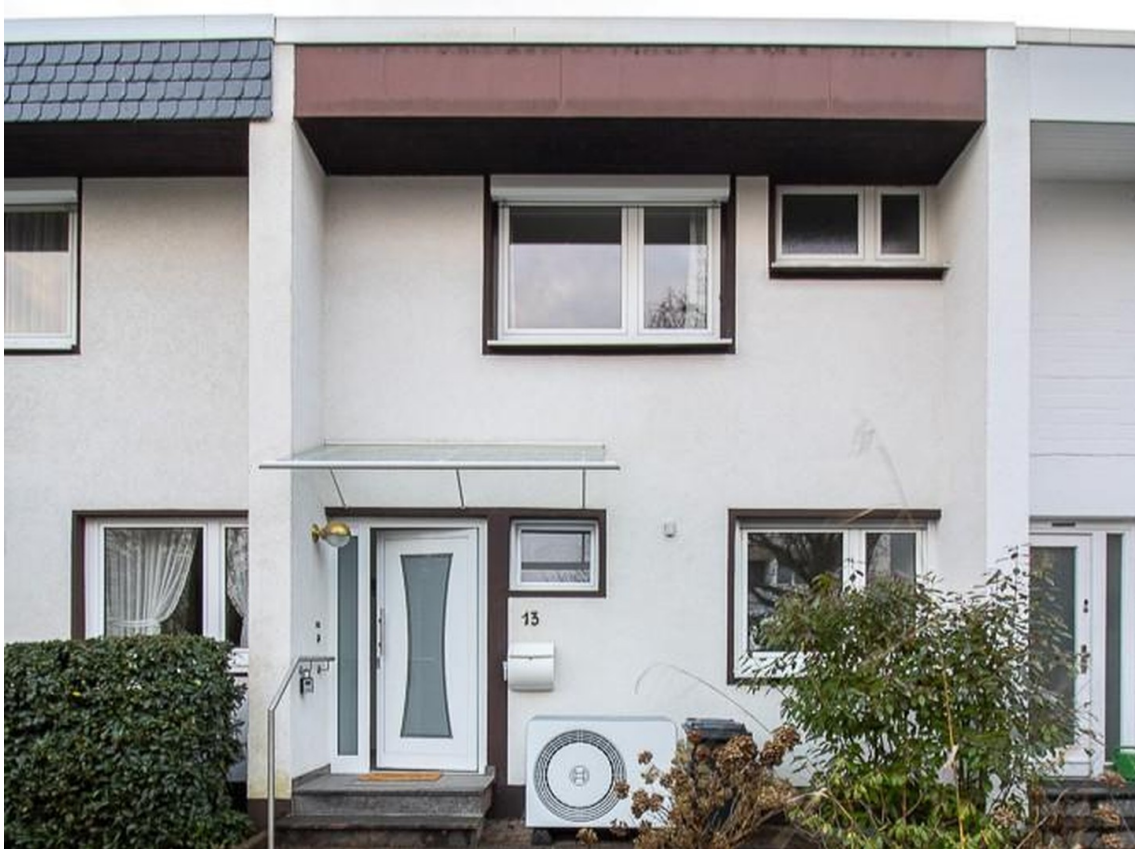
Neue BOSCH Wärmepumpe
