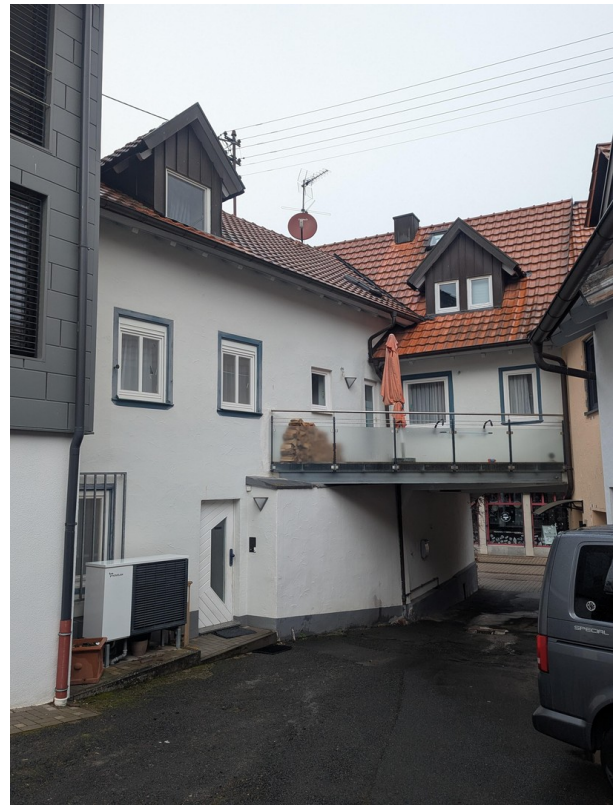
Außenansicht vom Hof
