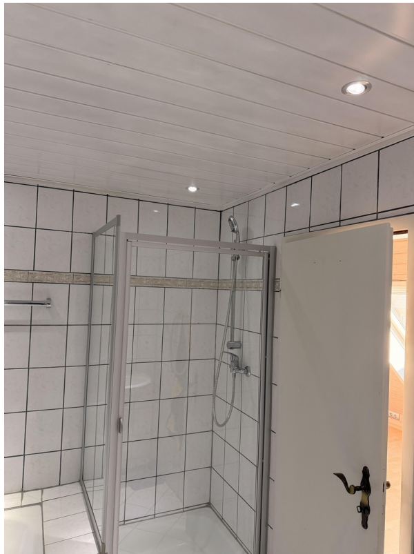
Badezimmer mit Wanne & Dusche
