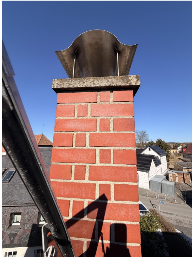
neu aufgebauter Schornsteinkop
