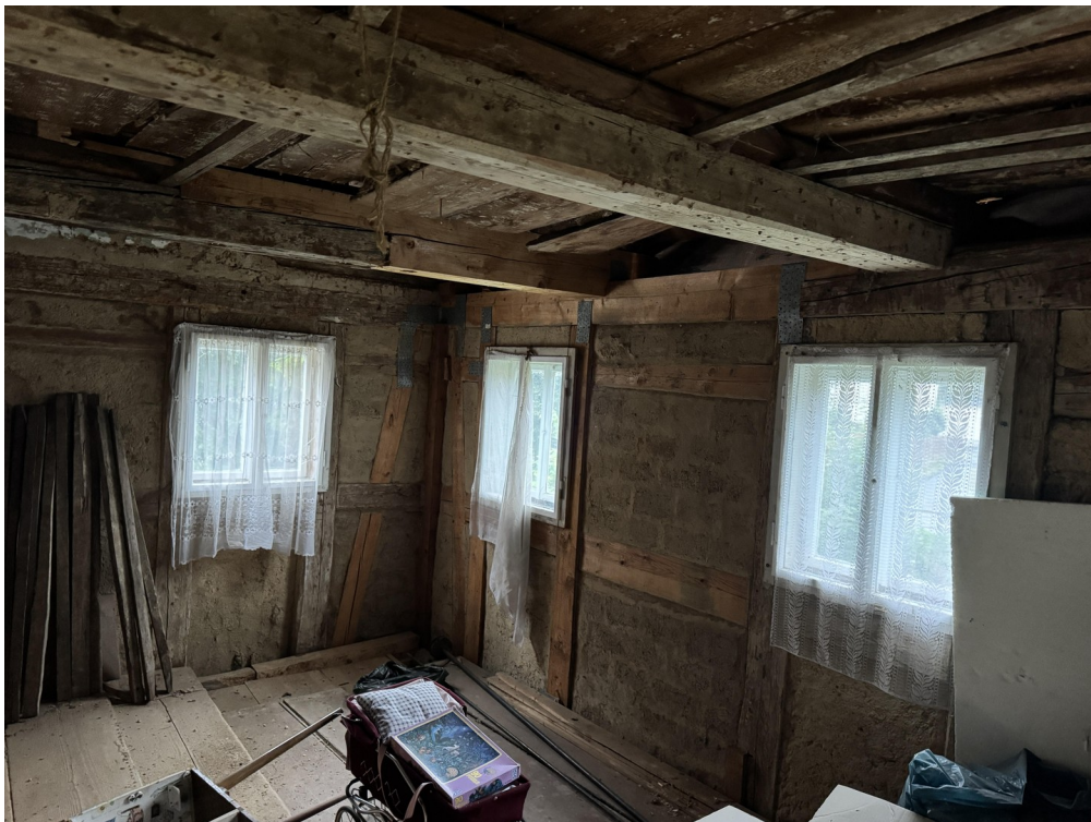
Neu aufgebaute Wand
