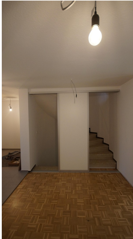
Treppenhaus Tür offen
