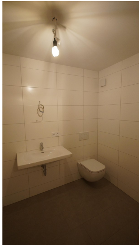
Bad WC 1.OG
