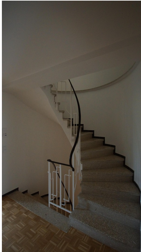
Treppe 1.OG zum Dach
