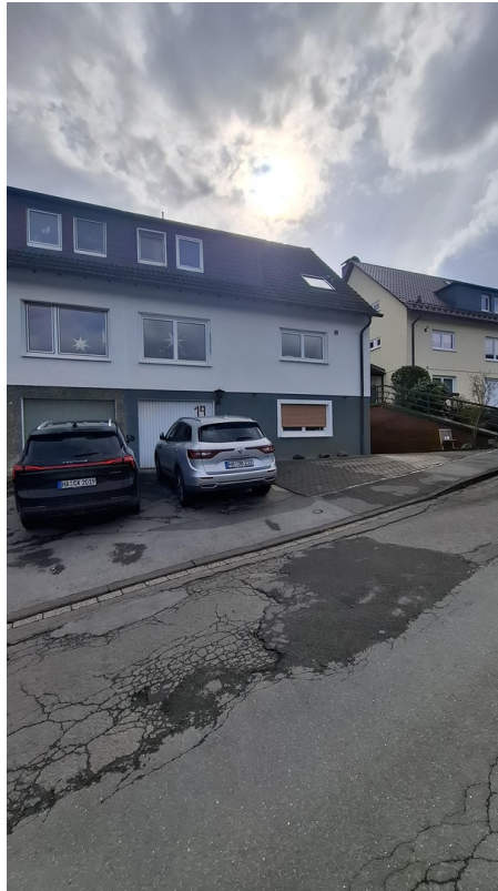
Haus mit Stellplatz
