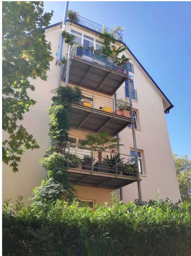
Hausansicht mit Balkon
