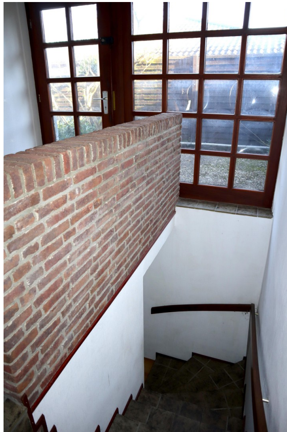
Eingang Treppe Keller
