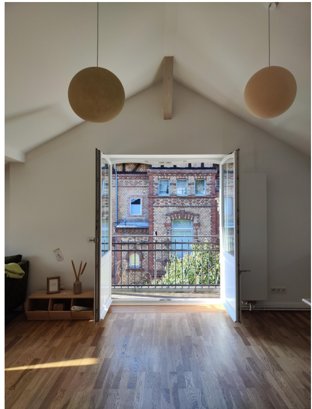
franz. Balkon im Wohnbereich
