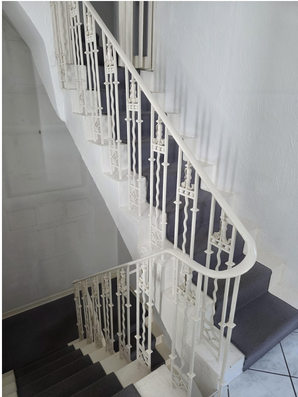
EG./1. OG. Treppenaufgang
