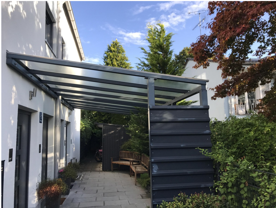
Eigener Eingang voll überdacht
