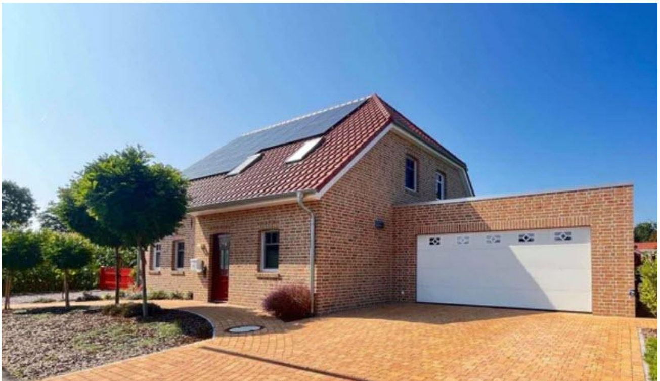
Ansicht mit Garage
