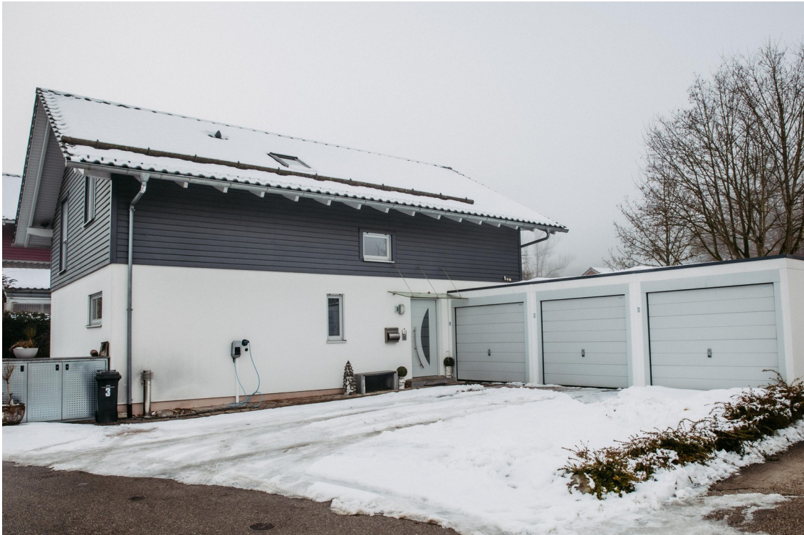
Eingang und Garagen
