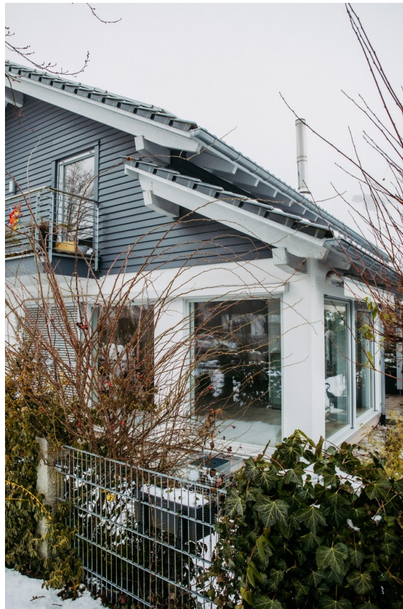
Wohnzimmer von außen
