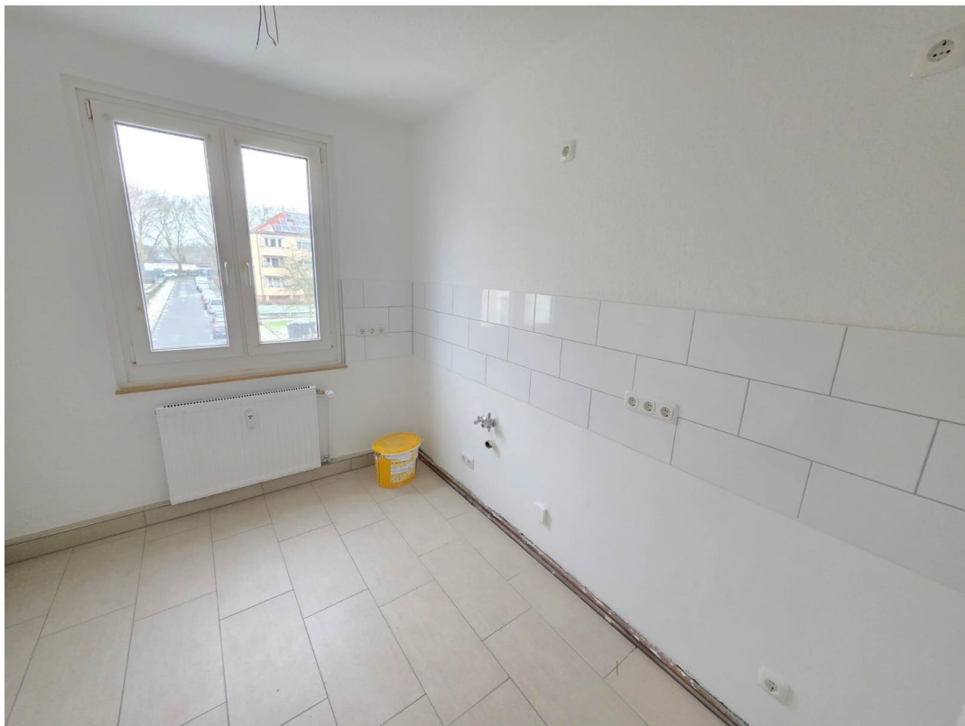
Küche neue Wand+Bodenfliesen
