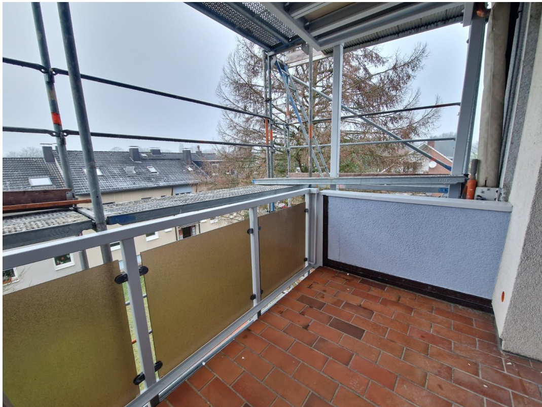
Balkon, Gerüste sind abgebaut
