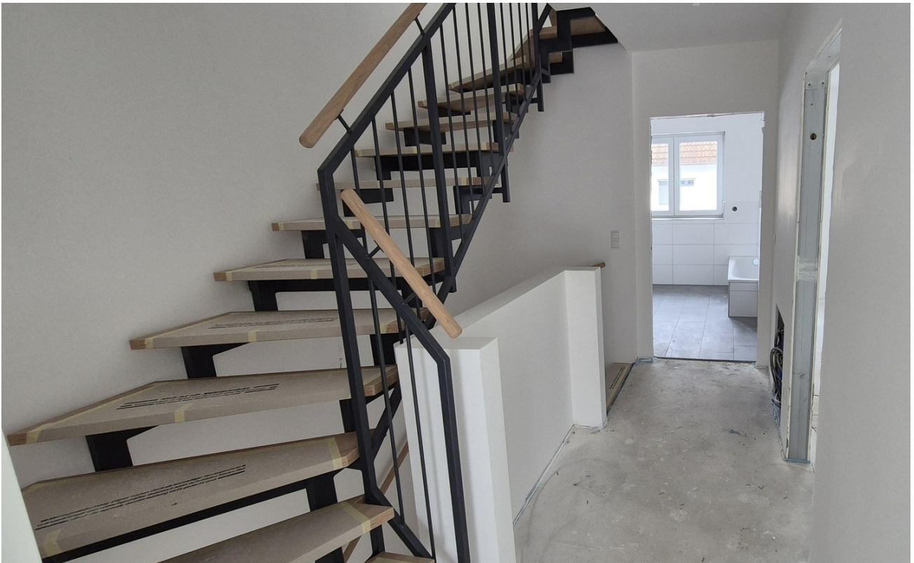
Treppe Flur OG
