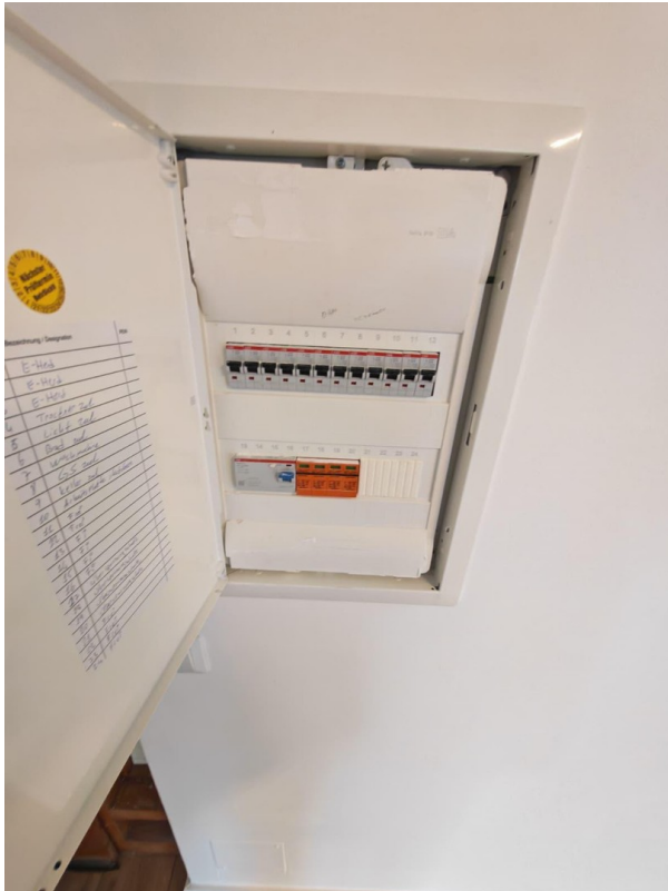
neue Elektrik inkl. FI
