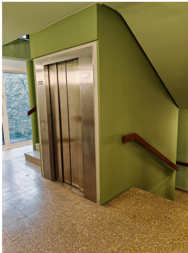
Treppenhaus mit Fahrstuhl
