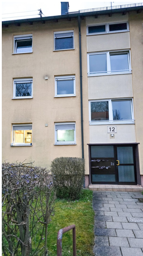
Fassade von Außen
