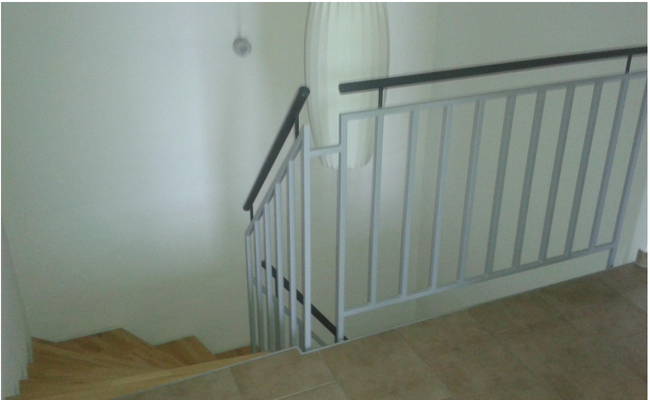
Teilansicht Flur OG
