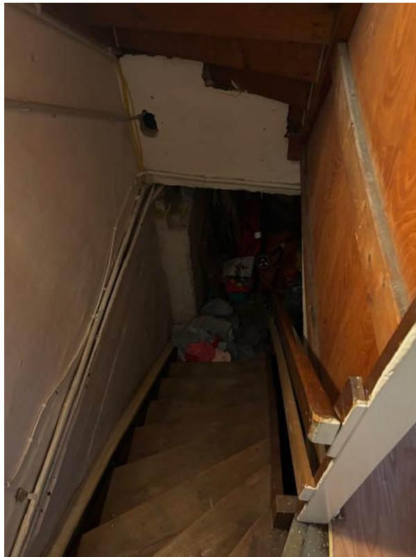
Treppe in den Keller
