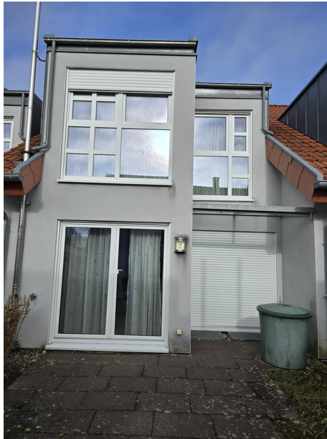
Hausansicht hinten (Südseite)
